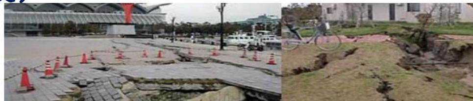
(左) 博多港中央ふ頭におけるイベントヤードのブロック舗装の亀裂・陥没状況 (九州地方整備局より提供)
